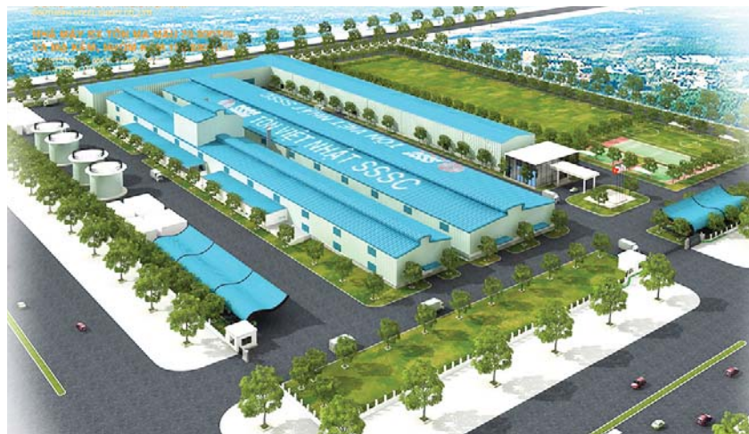
Nhà máy mới của Công ty Tôn Phương Nam tại KCN Nhơn Trạch II, Đồng Nai sắp đi vào hoạt động.
